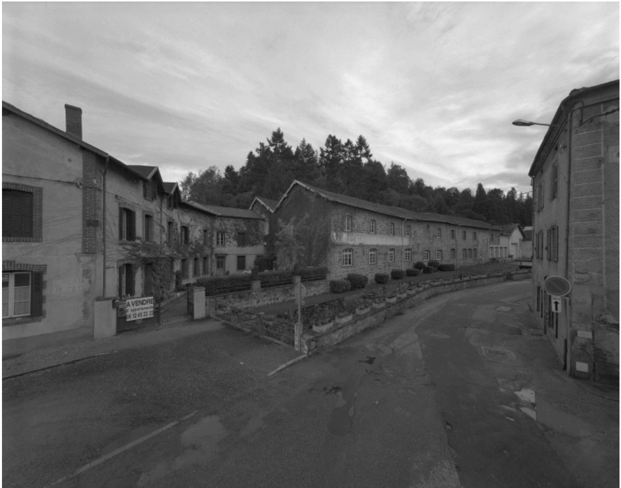
Vue d'ensemble de l'usine de mise en bouteille des eaux minérales et des logements sur la rive droite du Chagnon.
