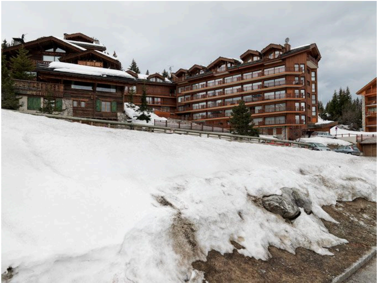
Vue d'ensemble du Pralong surélevé et modifié
