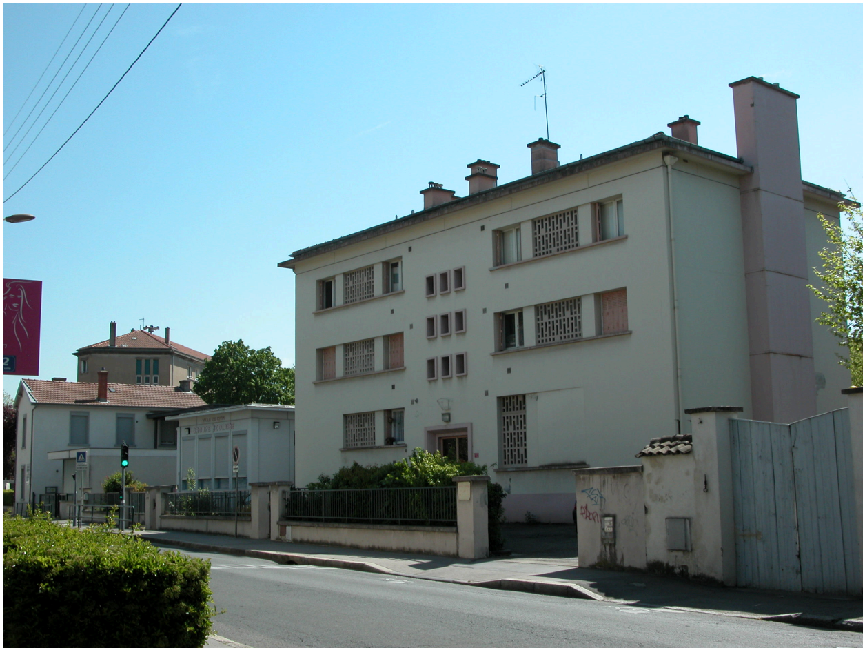
Vue de situation de la façade nord
