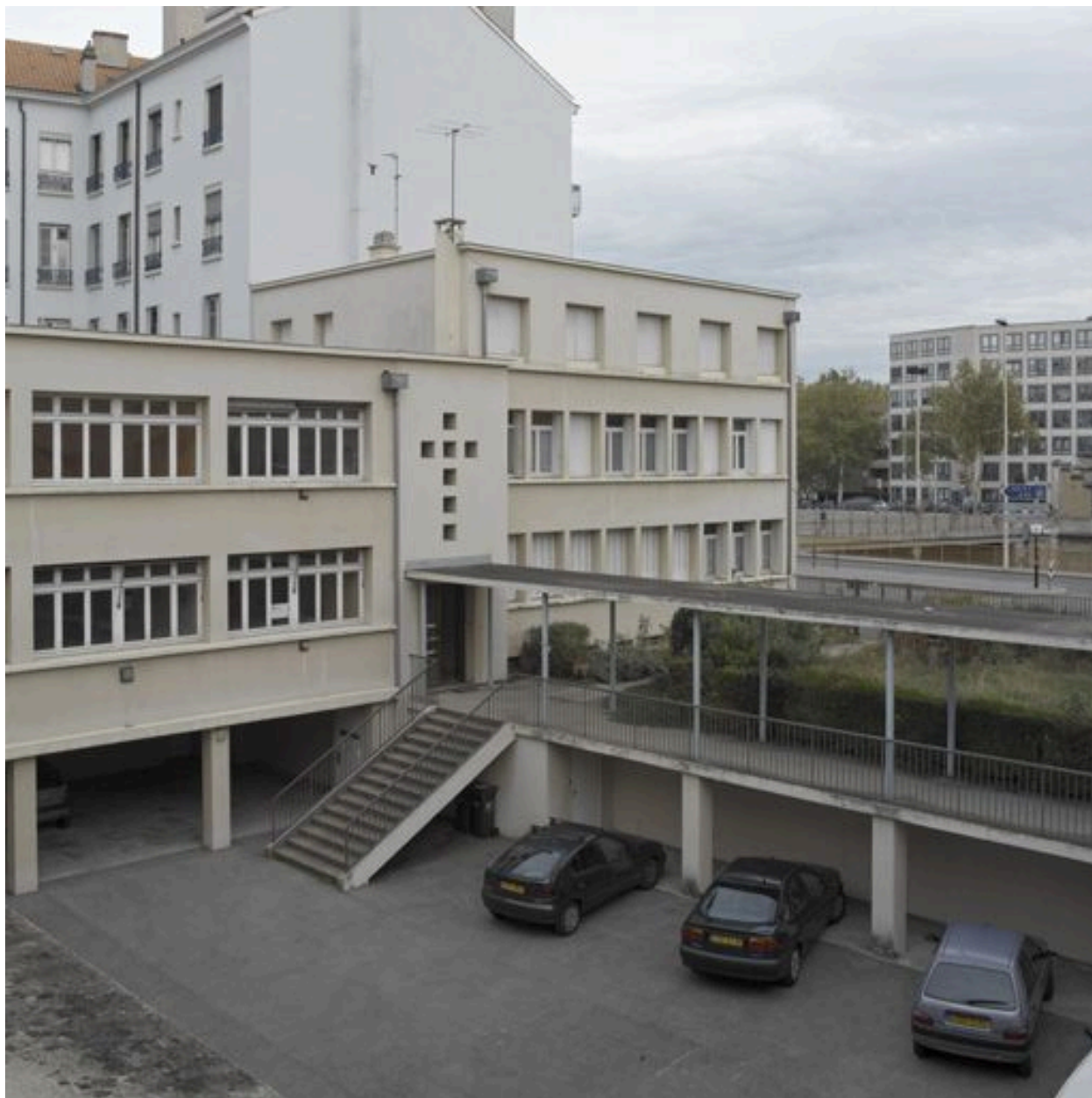
Vue d'ensemble du presbytère et de la galerie de passage depuis le sud-ouest
