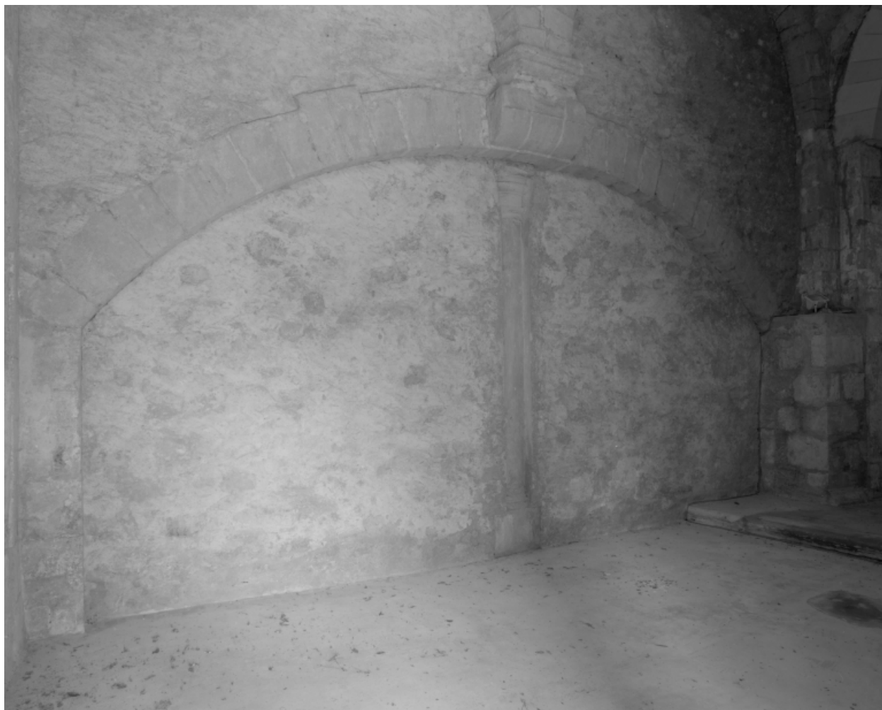
Elévation intérieure, mur nord : structure d'un arc de décharge latéral s'étendant sur deux travées.
