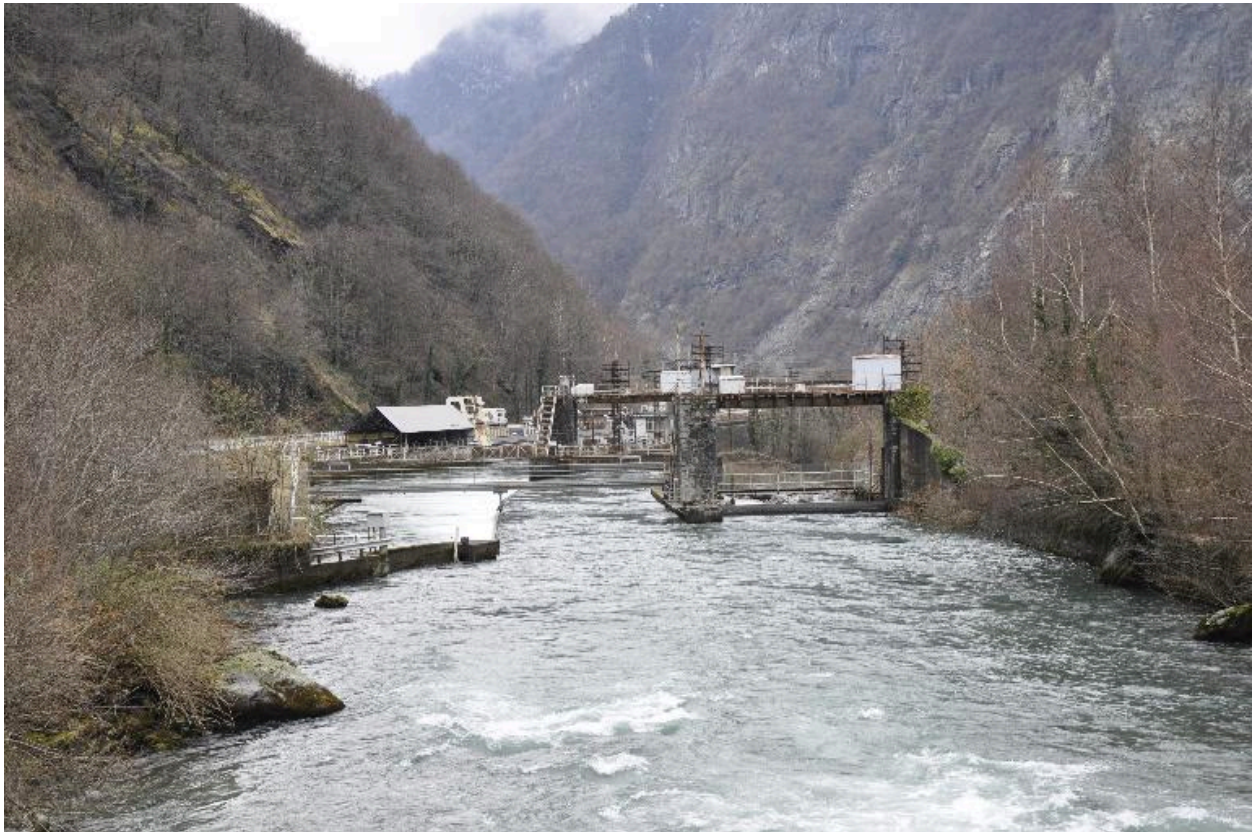
Vue du barrage de Rioupéroux
