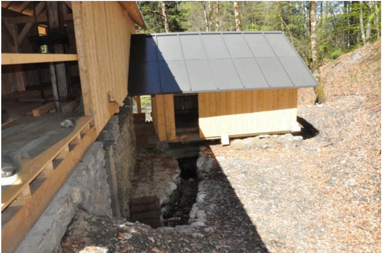
La partie moulin en cours de restauration, 2015.
