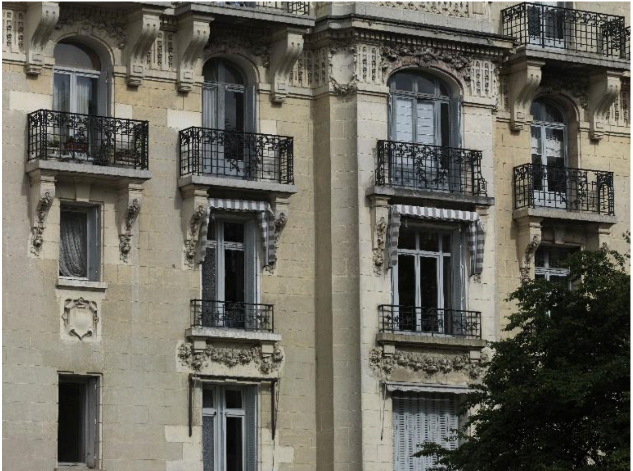
Façade sur cour: baies des 3e et 4e étages
