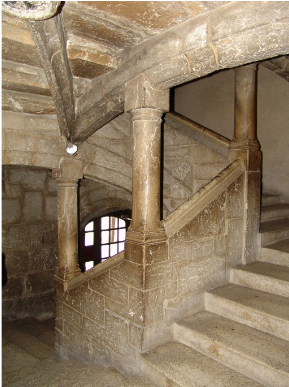
Vue du grand escalier au niveau du 1er étage
