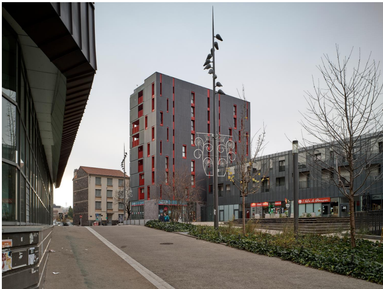
Elargissement de la rue Kessler formant parvis à l'Ecole d'art, en vis-à-vis la résidence
