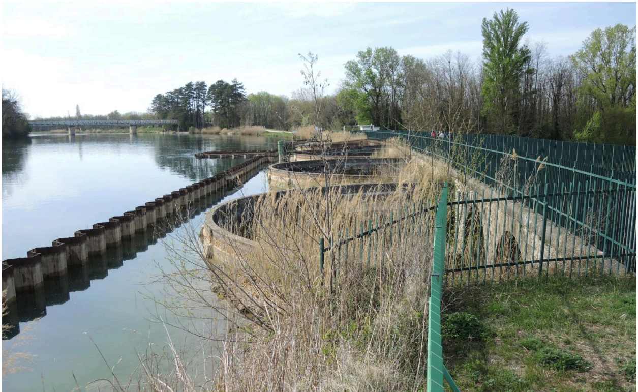
Vue d'ensemble du déversoir d'Herbens
