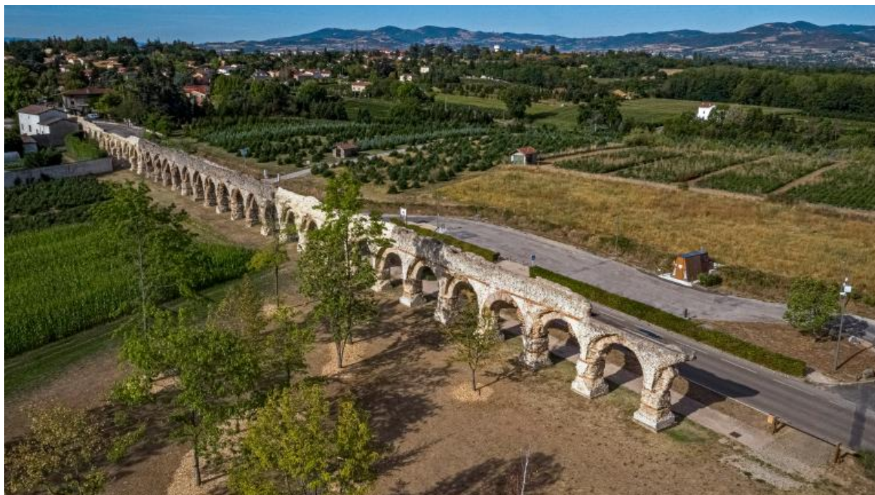
Vue général de l'aqüeduc du Gier au lieu dit du Plat de l'Air à Chaponost. (drône)
