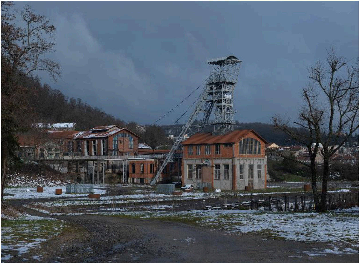
Vue d'ensemble nord du puits Couriot
