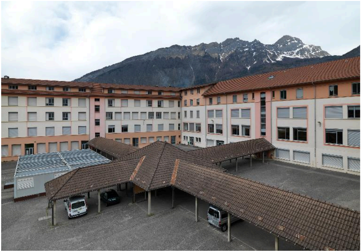
Elévation sur cour des bâtiments B et C, depuis l'est
