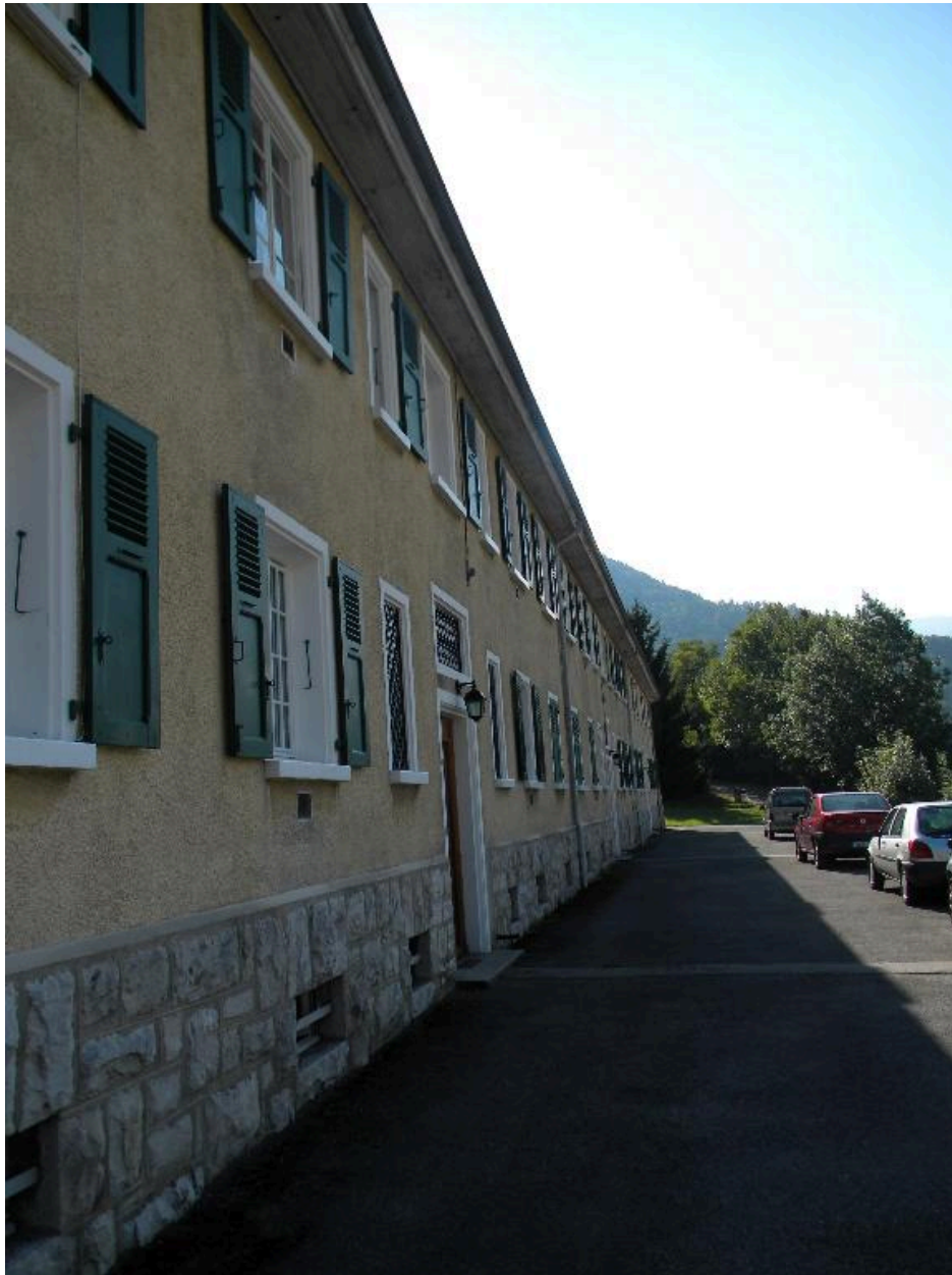
Détail de la façade principale.
