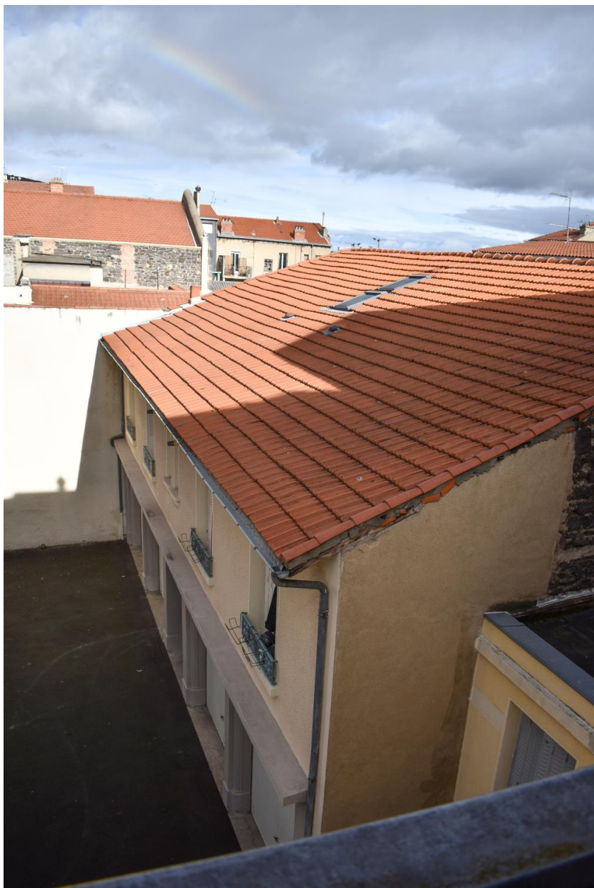
Façade sur cour du 21 avenue d'Italie
