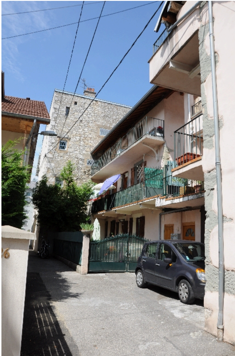
Vue générale : élévation sur cour
