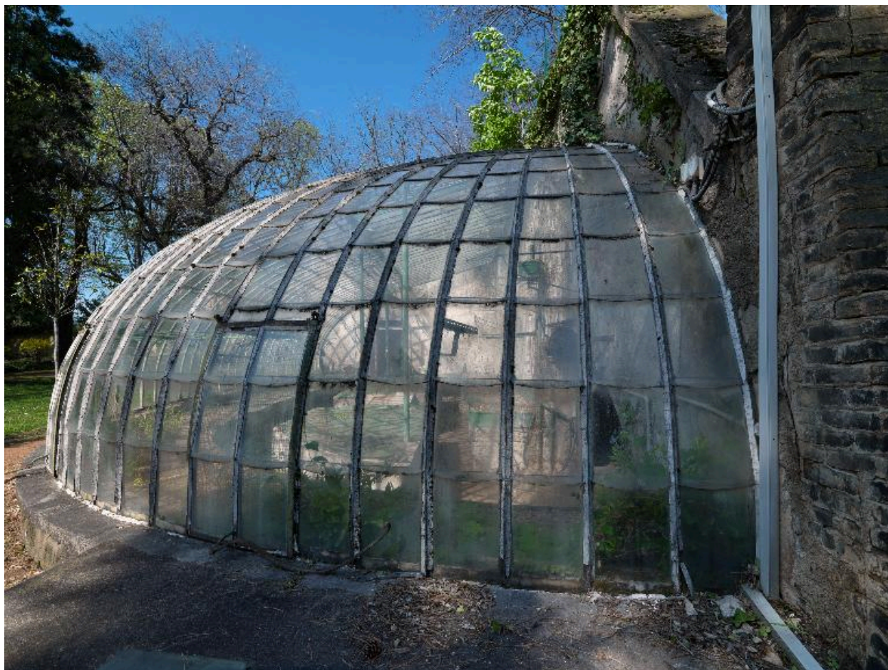
Serre, détail de la paroi vitrée
