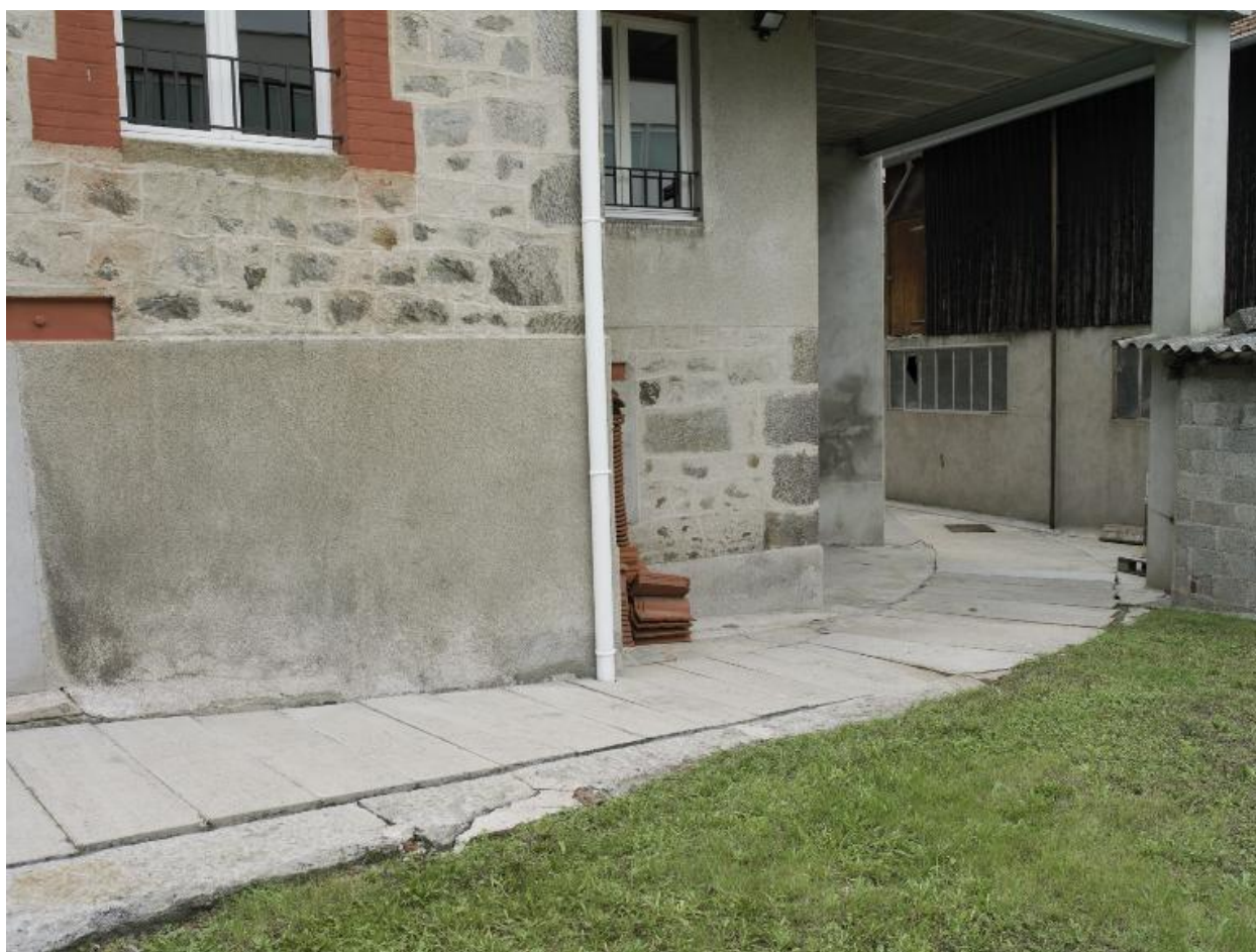
Vue sur la partie canalisée du bief.
