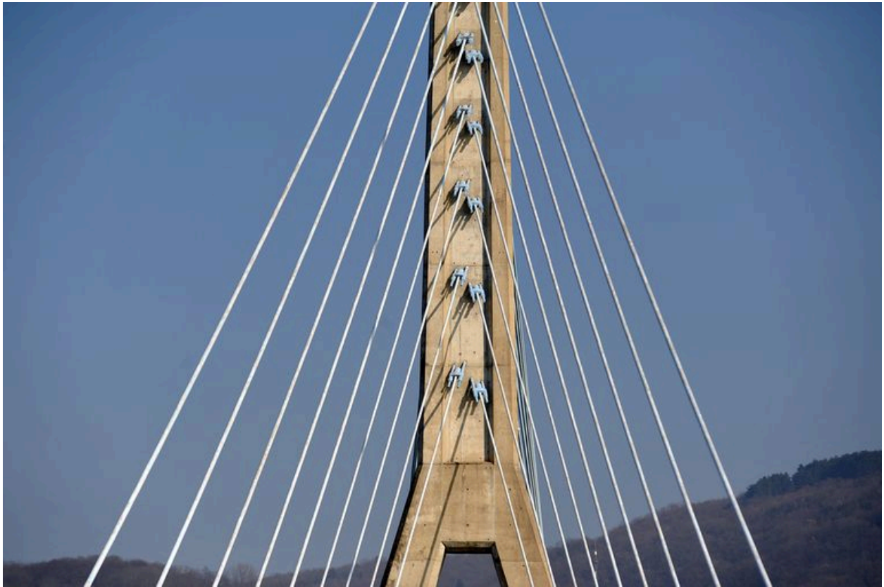
Pylône central, vue de détail : ancrage des câbles (depuis la rive gauche)
