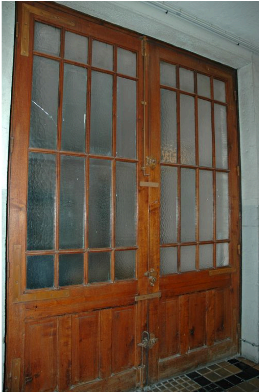
Porte ouvrant sur la cour
