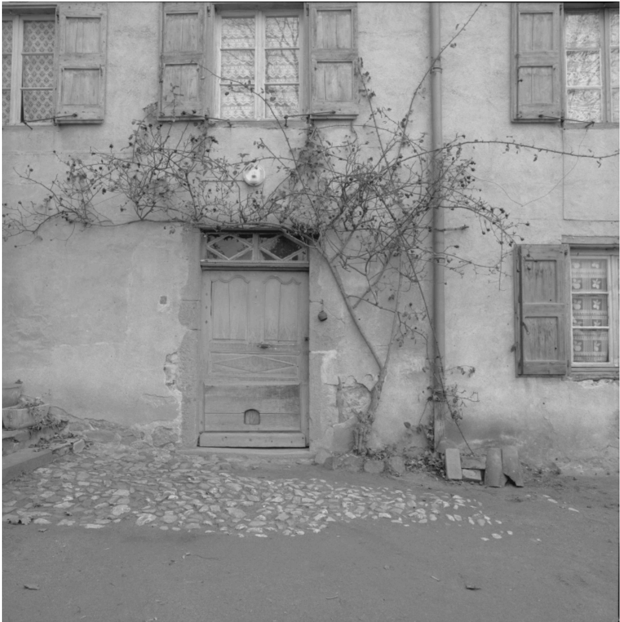
Détail de l'élévation antérieure de l'ancien logis.
