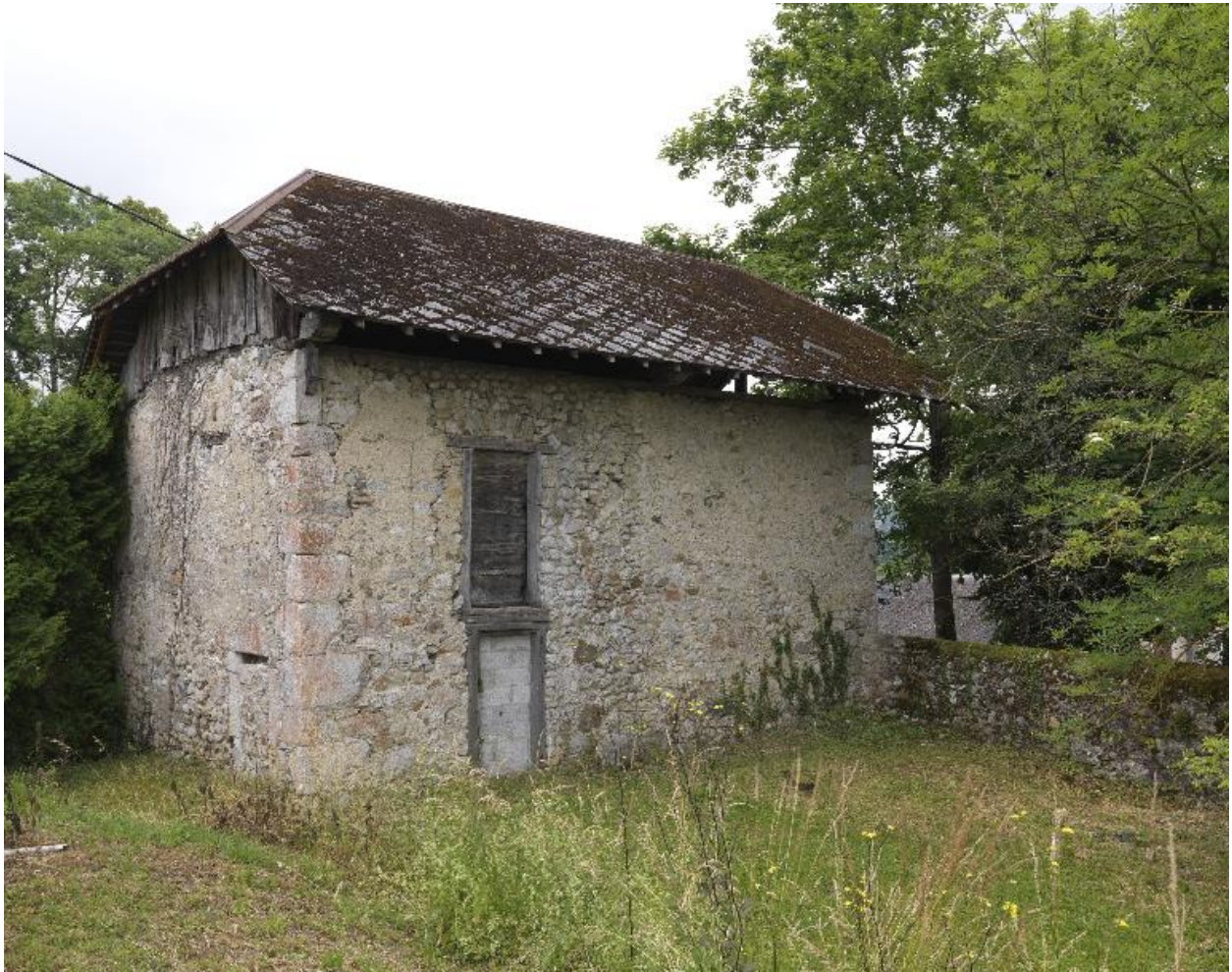
Vue d'ensemble de trois-quart arrière du logis de la ferme du château.
