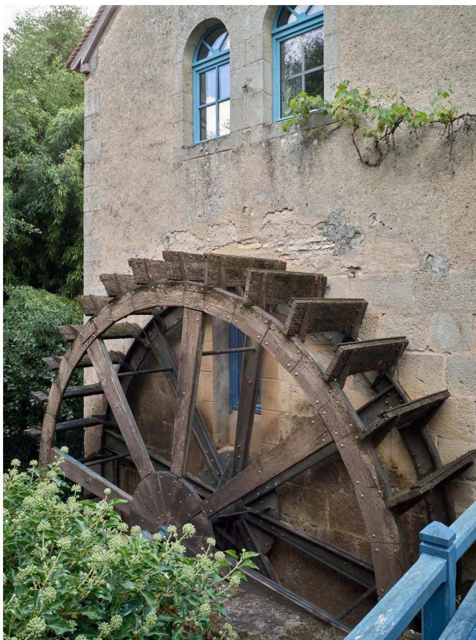
Détail de la roue hydraulique verticale
