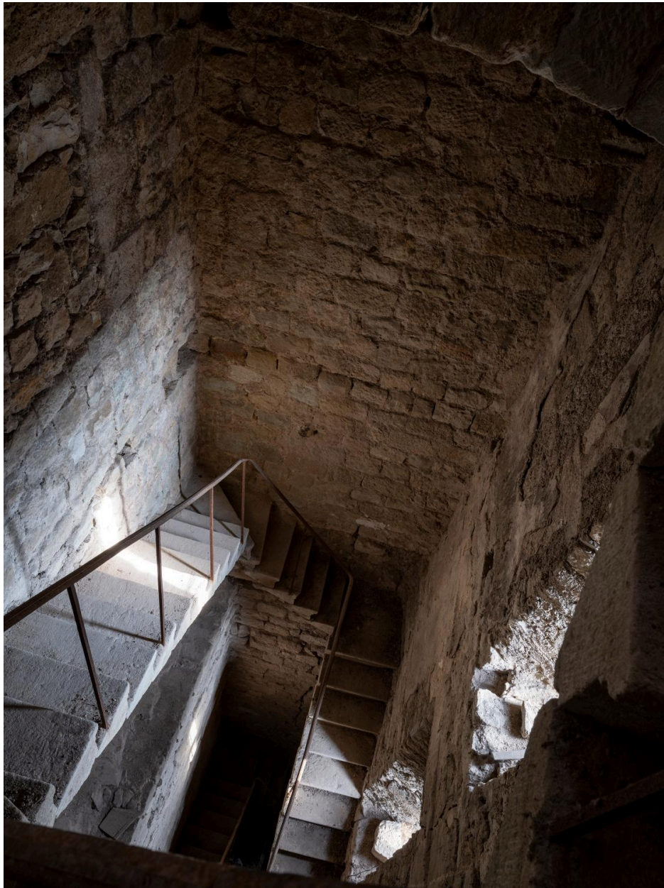
Tour de l'horloge, escalier
