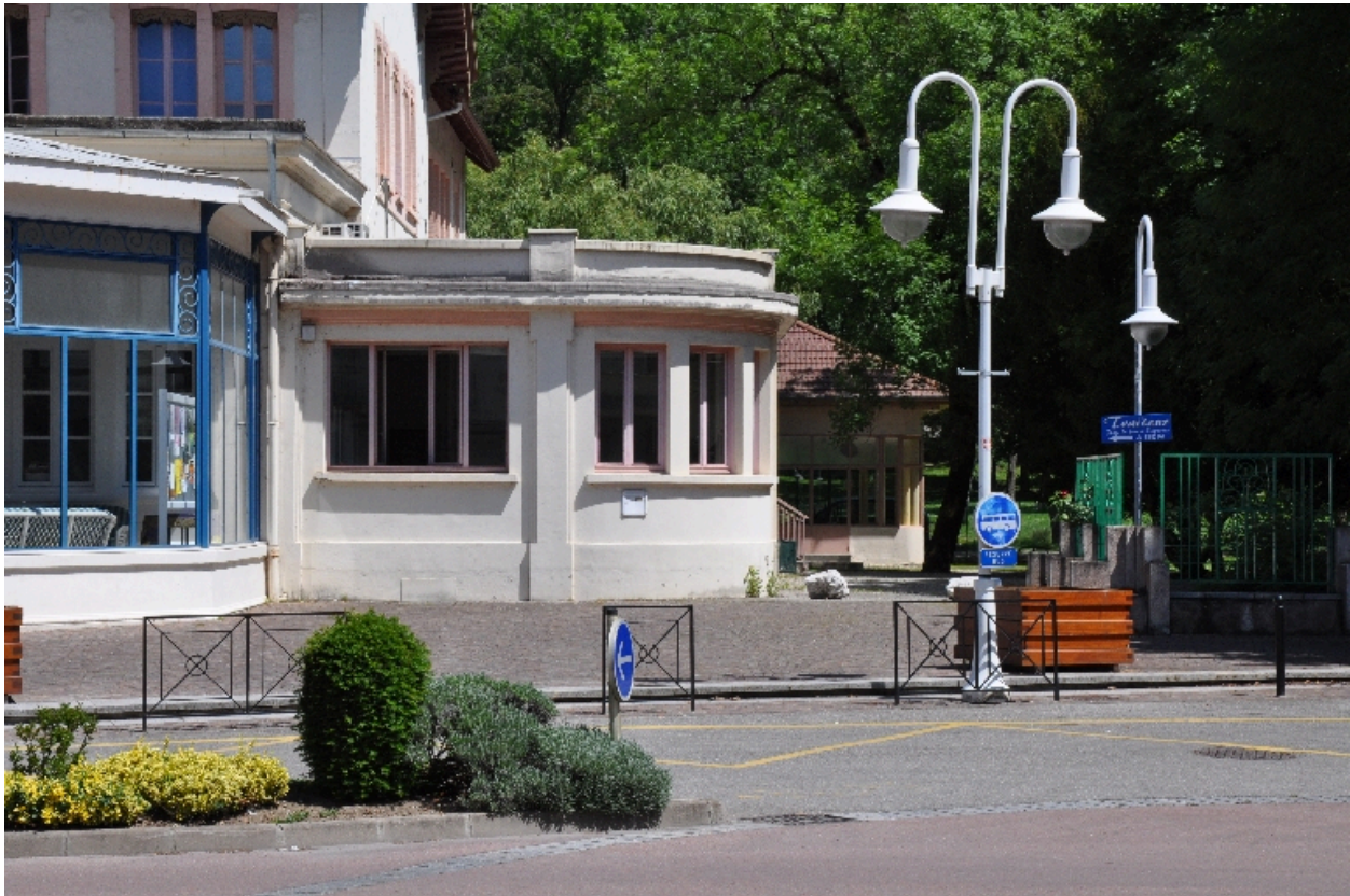
Vue d'une des ailes latérales du bâtiment
