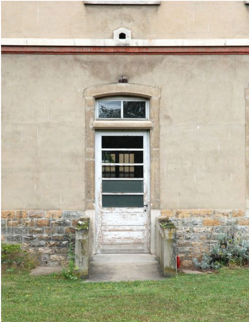
Façade postérieure sud, porte avec encadrement en pierre de taille d'origine
