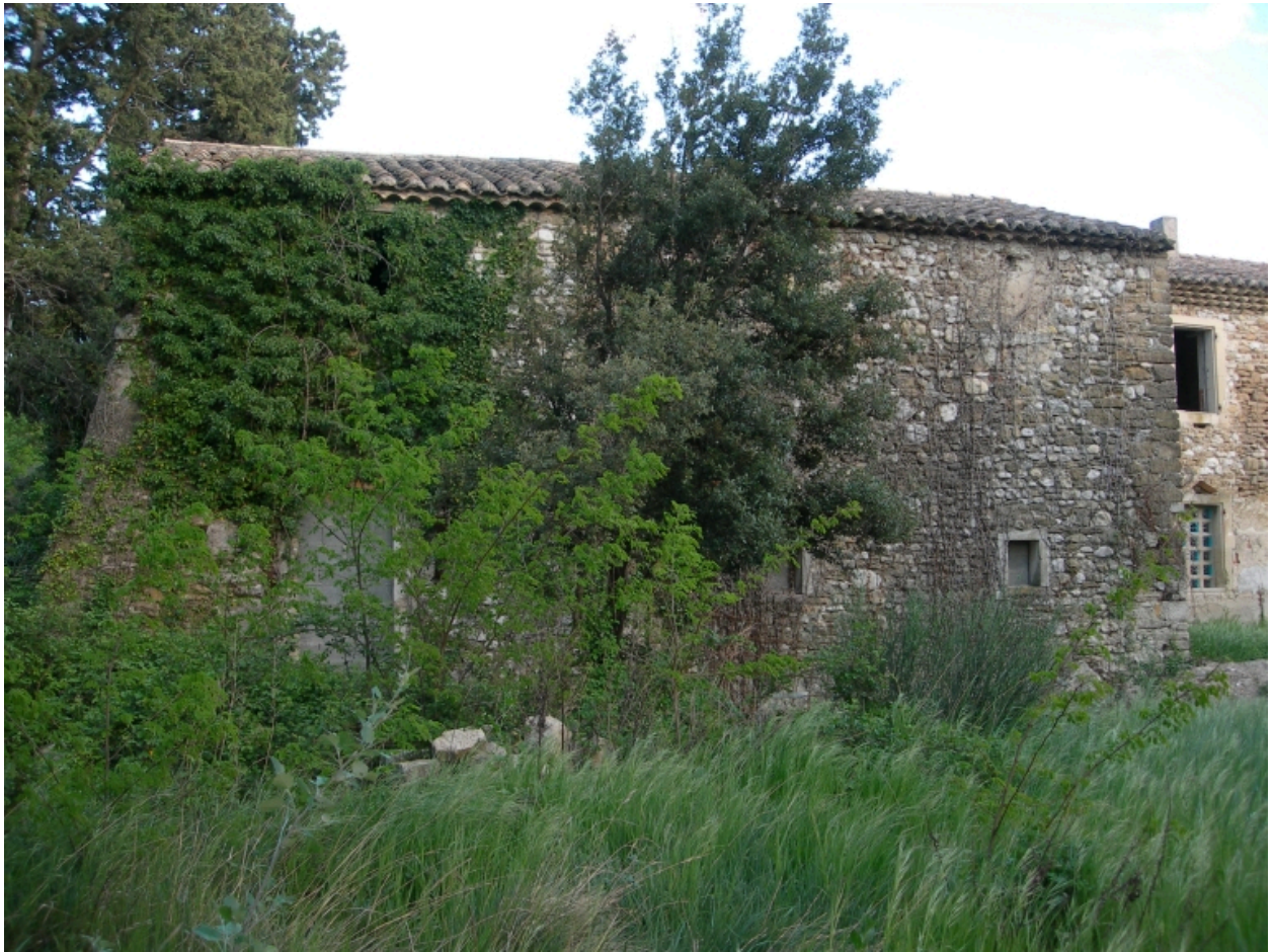
Vue d'ensemble du bâtiment prise du nord-ouest : au 1er plan, le moulin.
