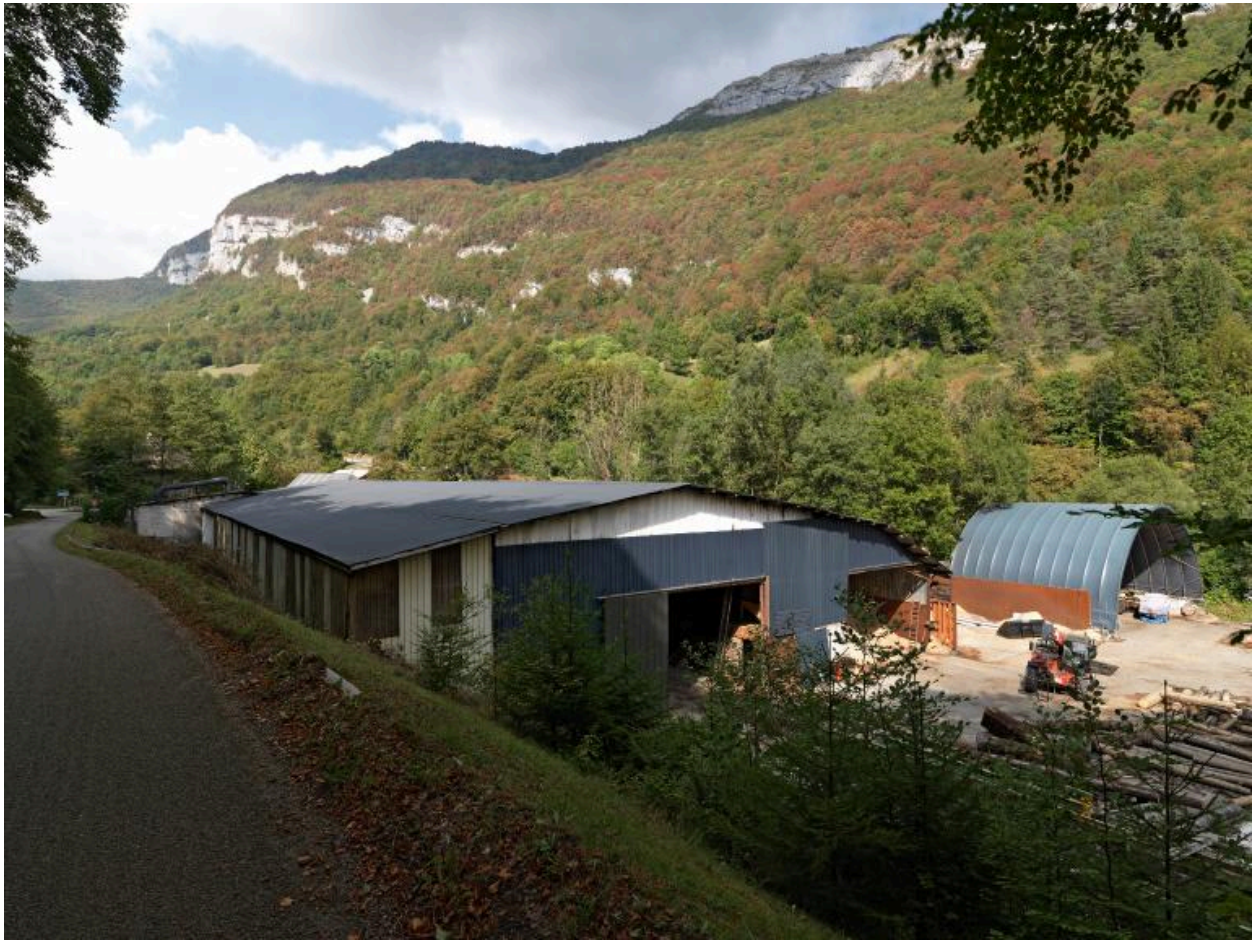
Vue d'ensemble du bâtiment abritant la scierie et l'espace de stockage du bois.
