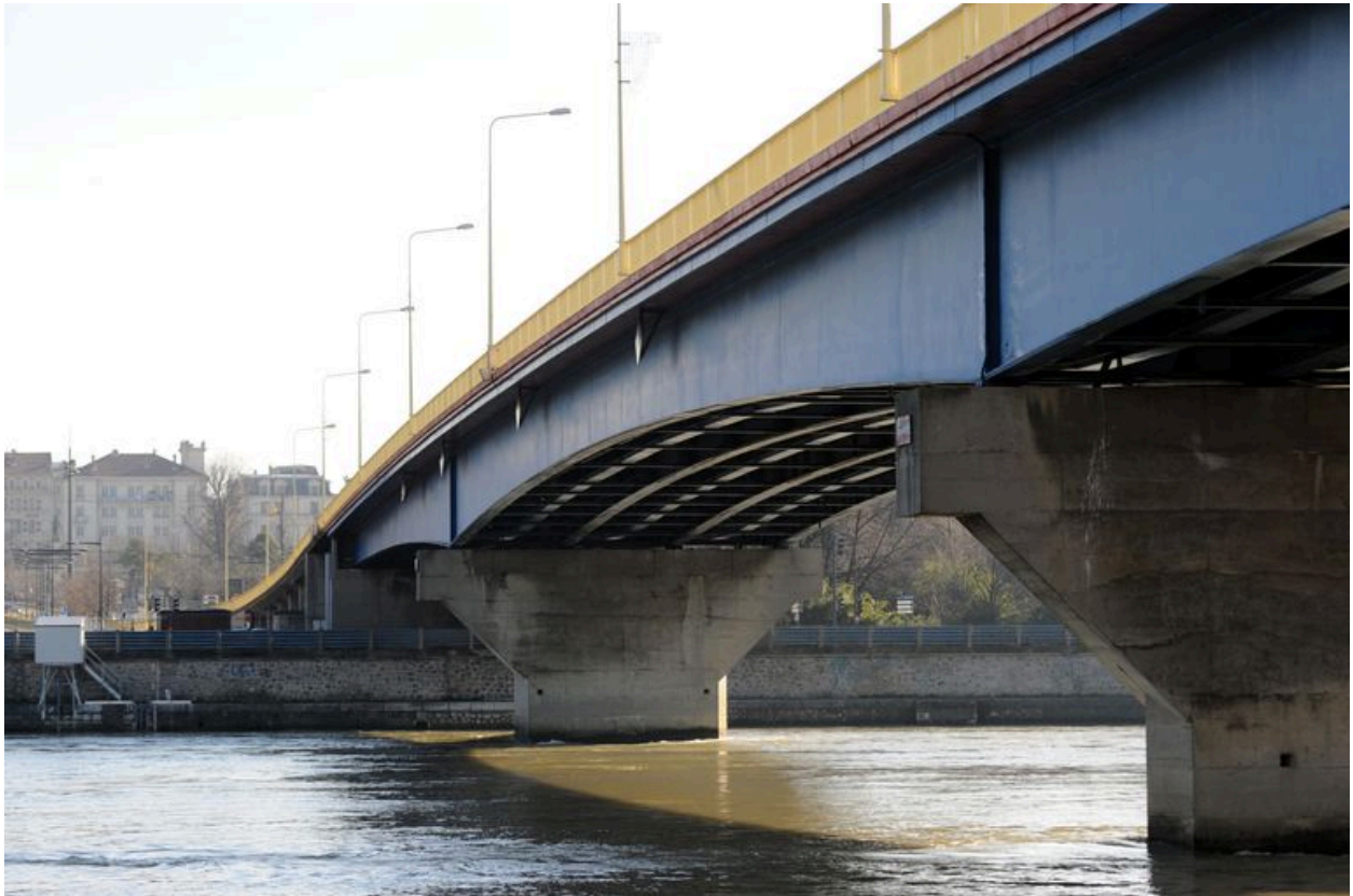
Vue partielle, de côté, face amont (depuis la rive droite)
