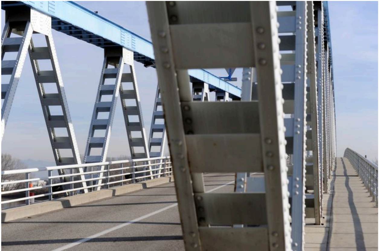
Vue partielle, de dessus, séparation des voies de circulation routière et piétonne (depuis la rive droite)
