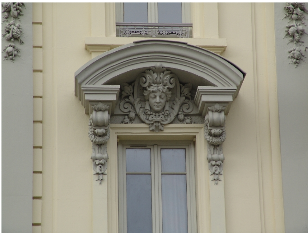
Façade antérieure : décor d'une baie
