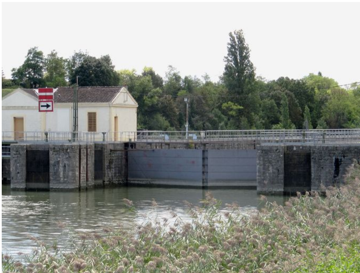
Ecluse, face amont (depuis la rive droite)
