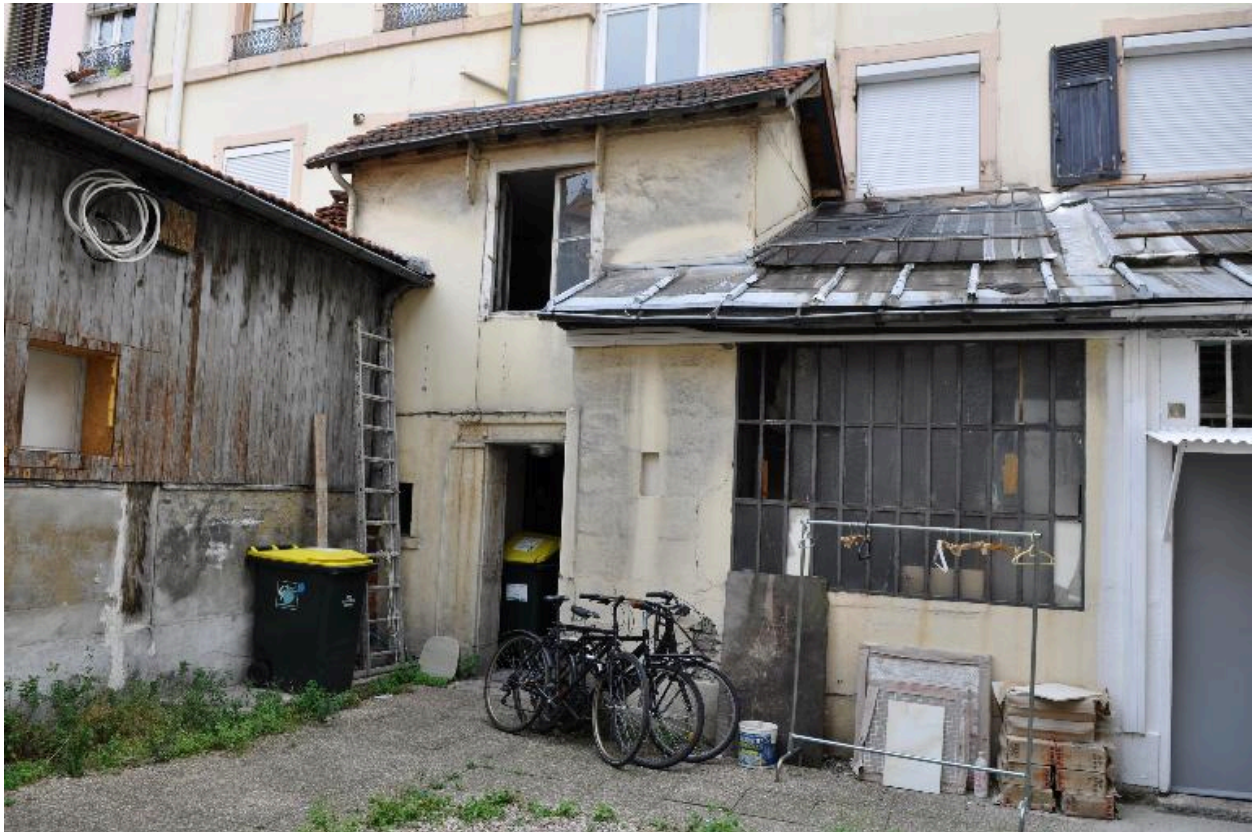
Vue partielle des bâtiments sur cour : hangar en pisé et essentage de planches, loge de concierge, hangar en pan de métal
