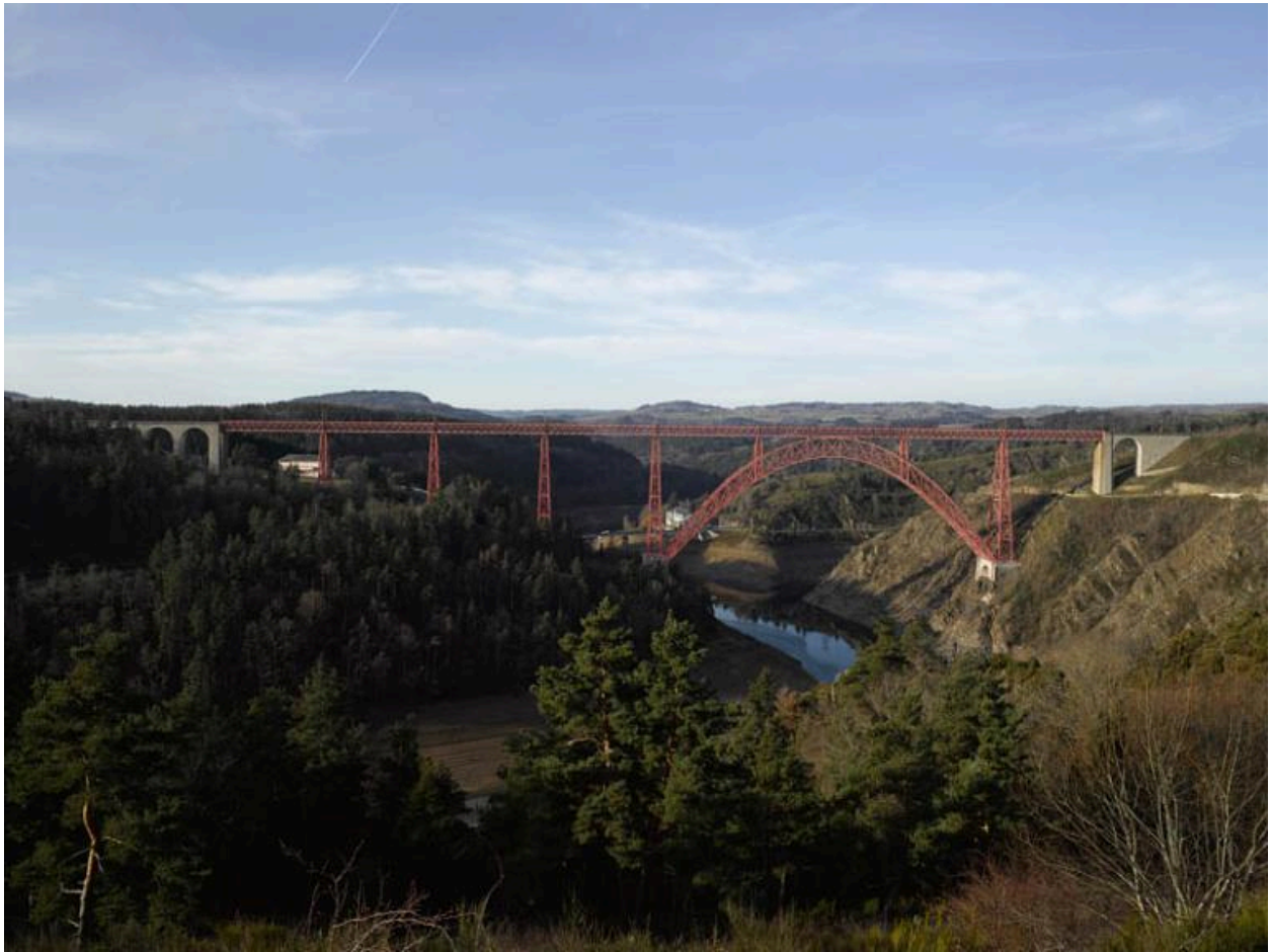
Vue générale du site du viaduc de Garabit.
