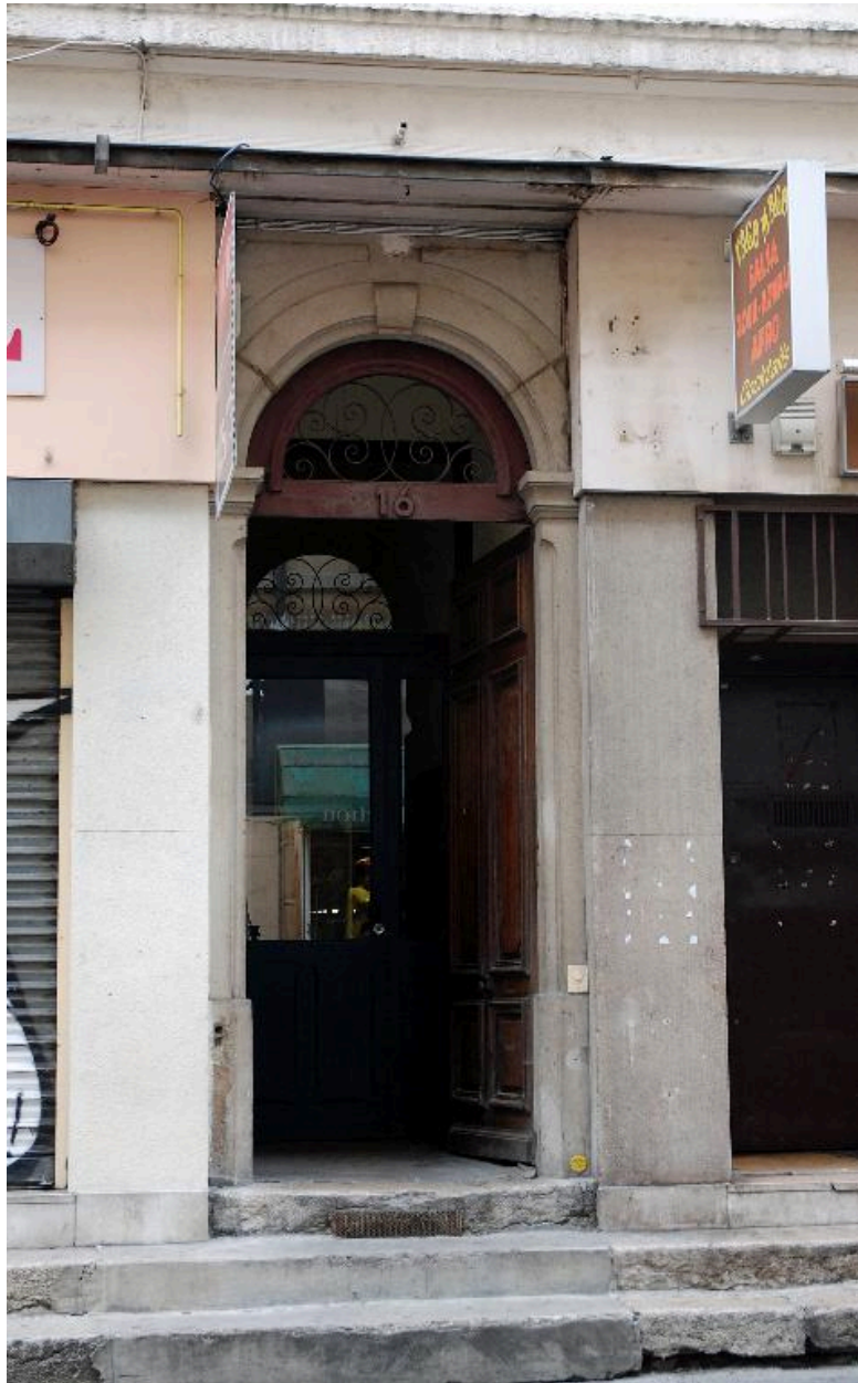
Immeuble sur rue : porte piétonne
