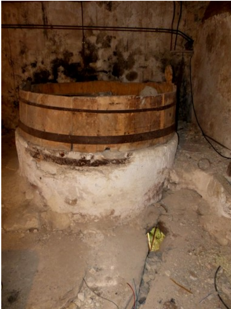
Bâtiment principal. Deuxième étage de soubassement, meunerie. Angle sud-est, moulin à huile.
