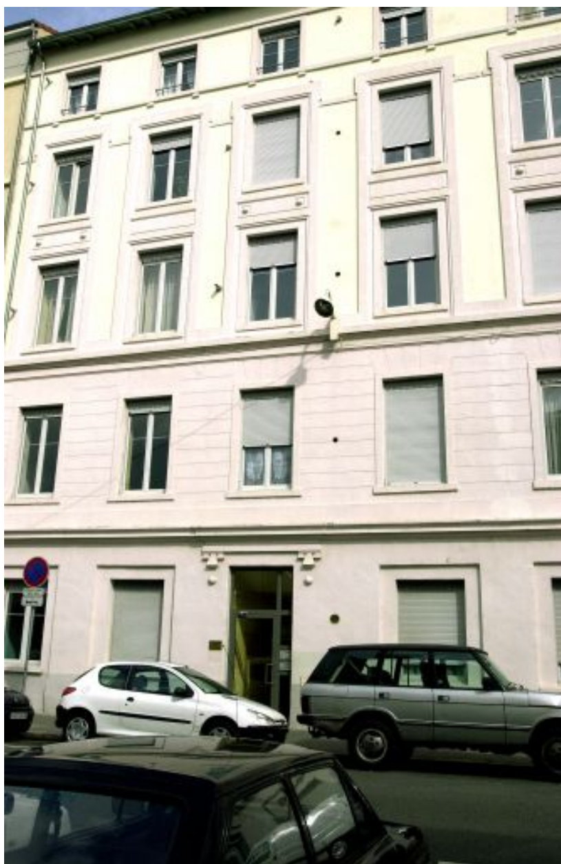
Détail de la travée d'entrée
