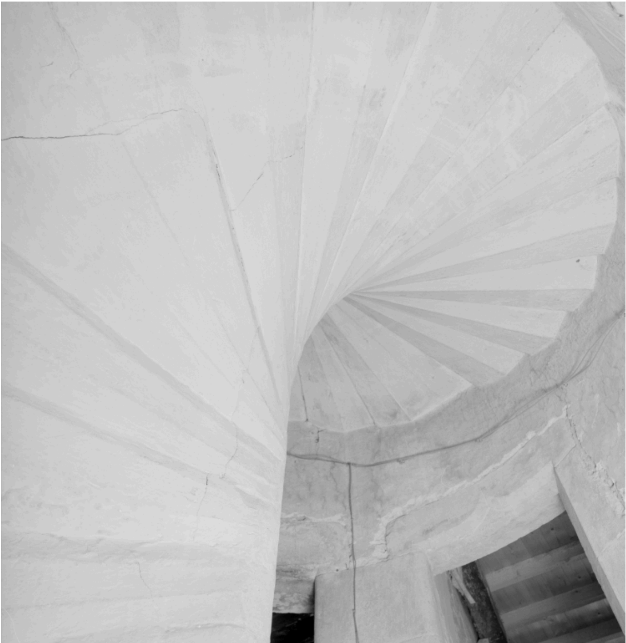
Couvrement de l'escalier en vis.
