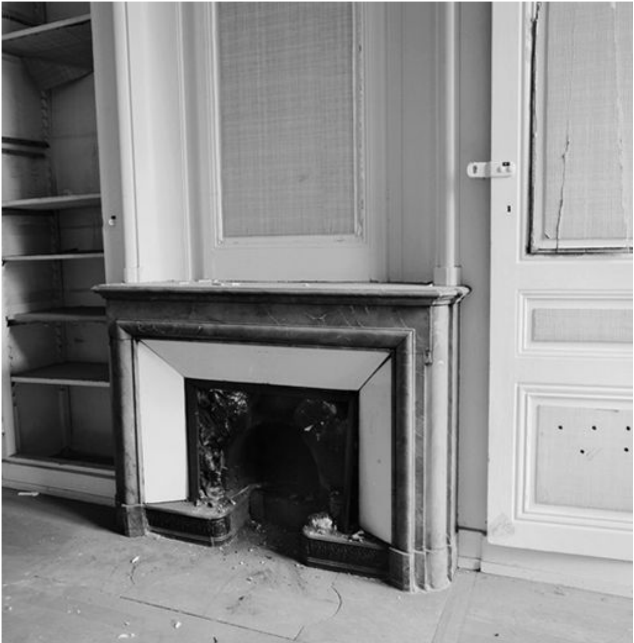
Bâtiment sur la place Carnot, 1er étage, cheminée de la pièce 27
