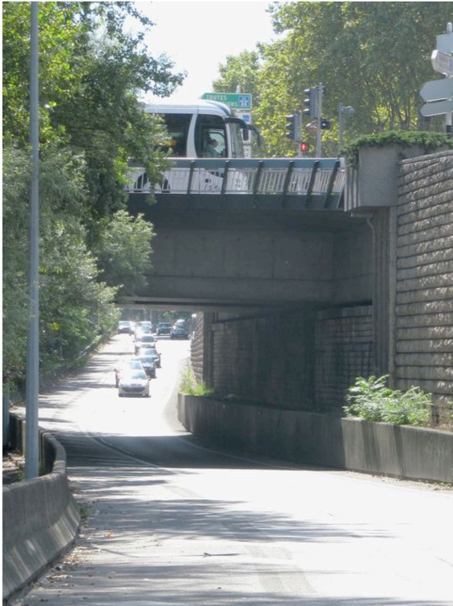
Travée de rive et culée droite, vue partielle, face amont (depuis la rive droite)
