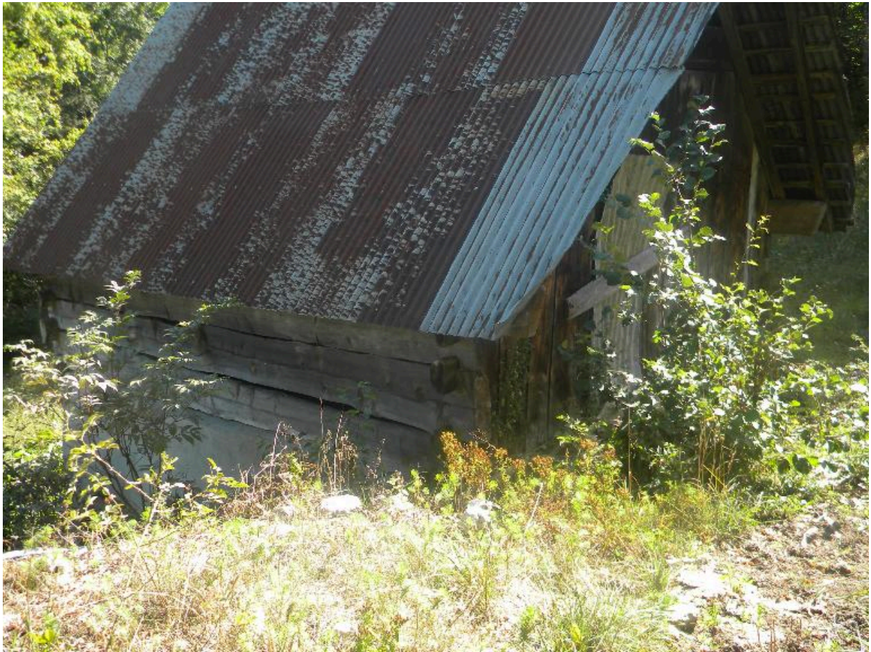
Vue de trois-quarts sud-ouest.
