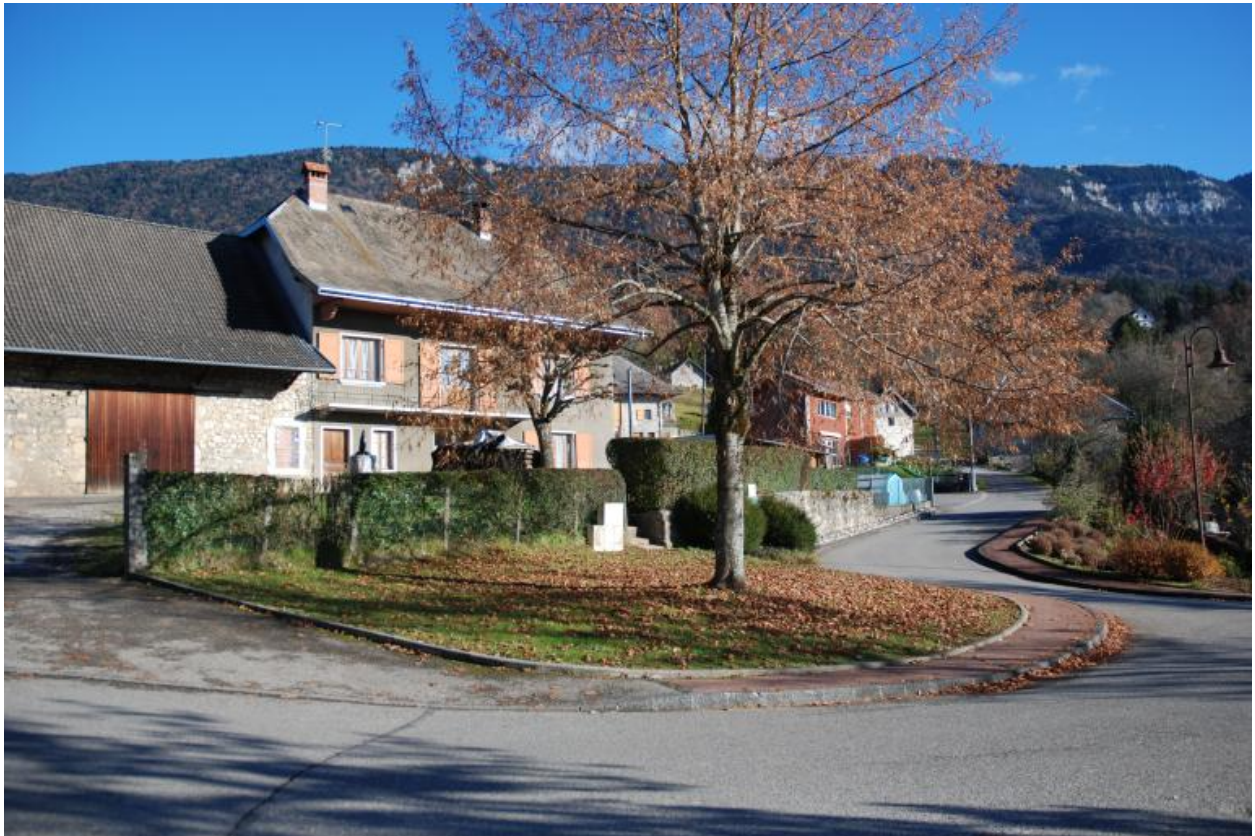
Vue partielle de Viuz-Sud. Parcelle C4 1978
