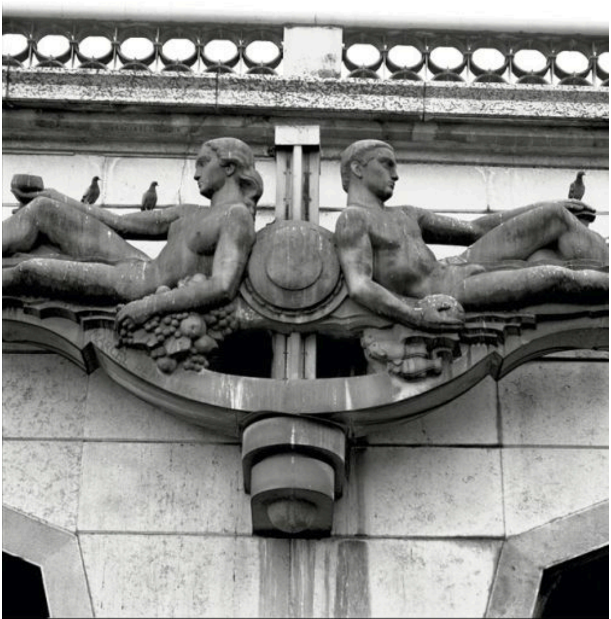
La pile ouest, côté nord, depuis la rivière : détail du bas-relief
