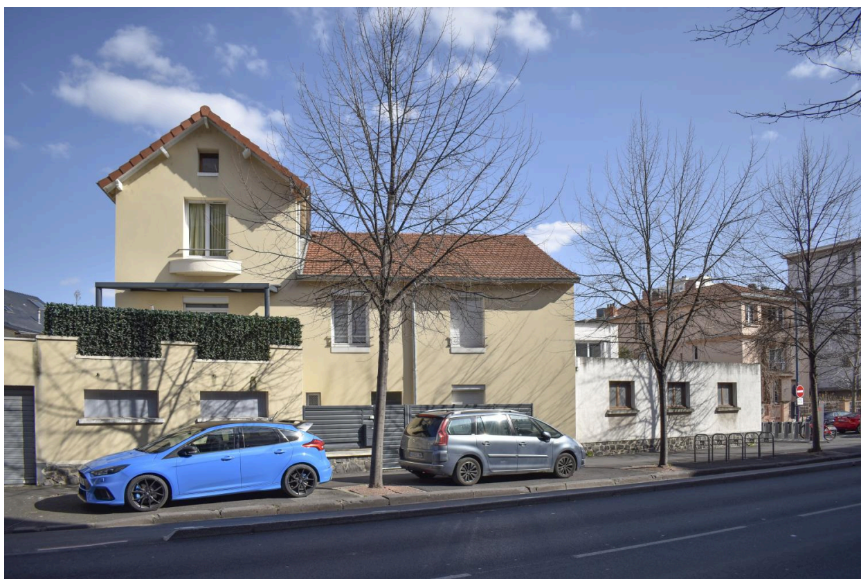
Façade sur le boulevard Aristide-Briand
