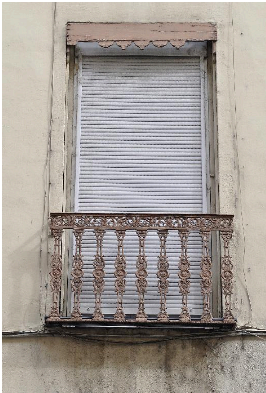
Détail d'une fenêtre du premier étage : garde-corps en ferronnerie
