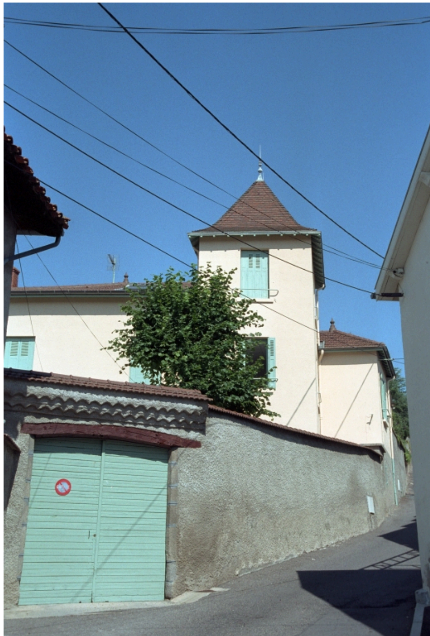
Boën, îlot 23, Alsace Lorraine (rue) 10. Vue générale de la maison.
