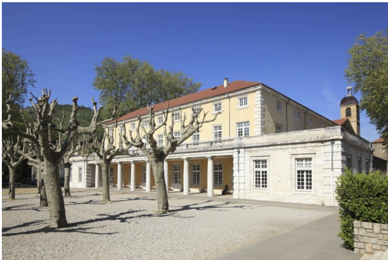
Bâtiment C. Façade sud.
