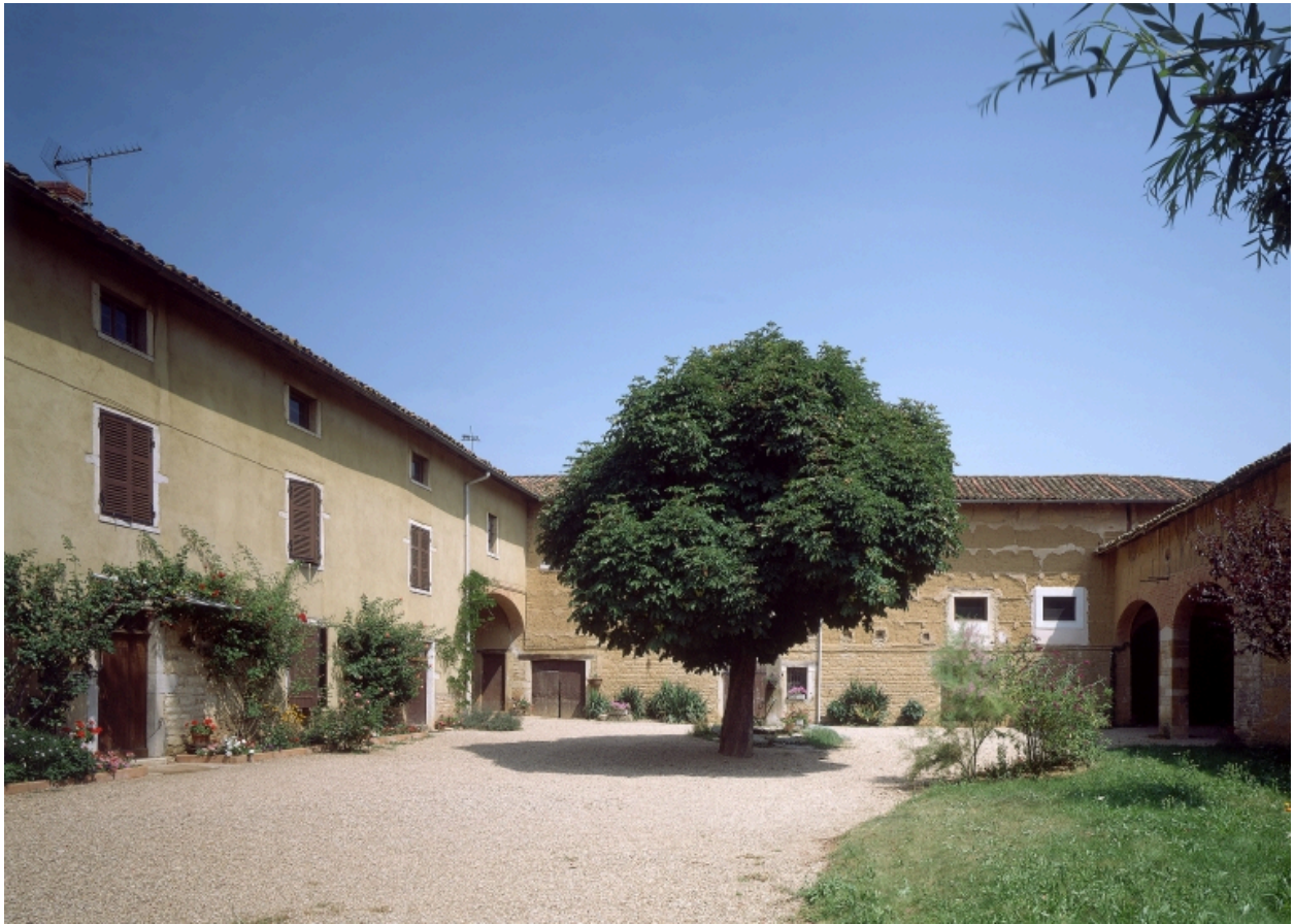
Vue d'ensemble sur cour depuis l'ouest : logis de maître à gauche, anciennes étables et fenil au fond, corps de porche à droite.
