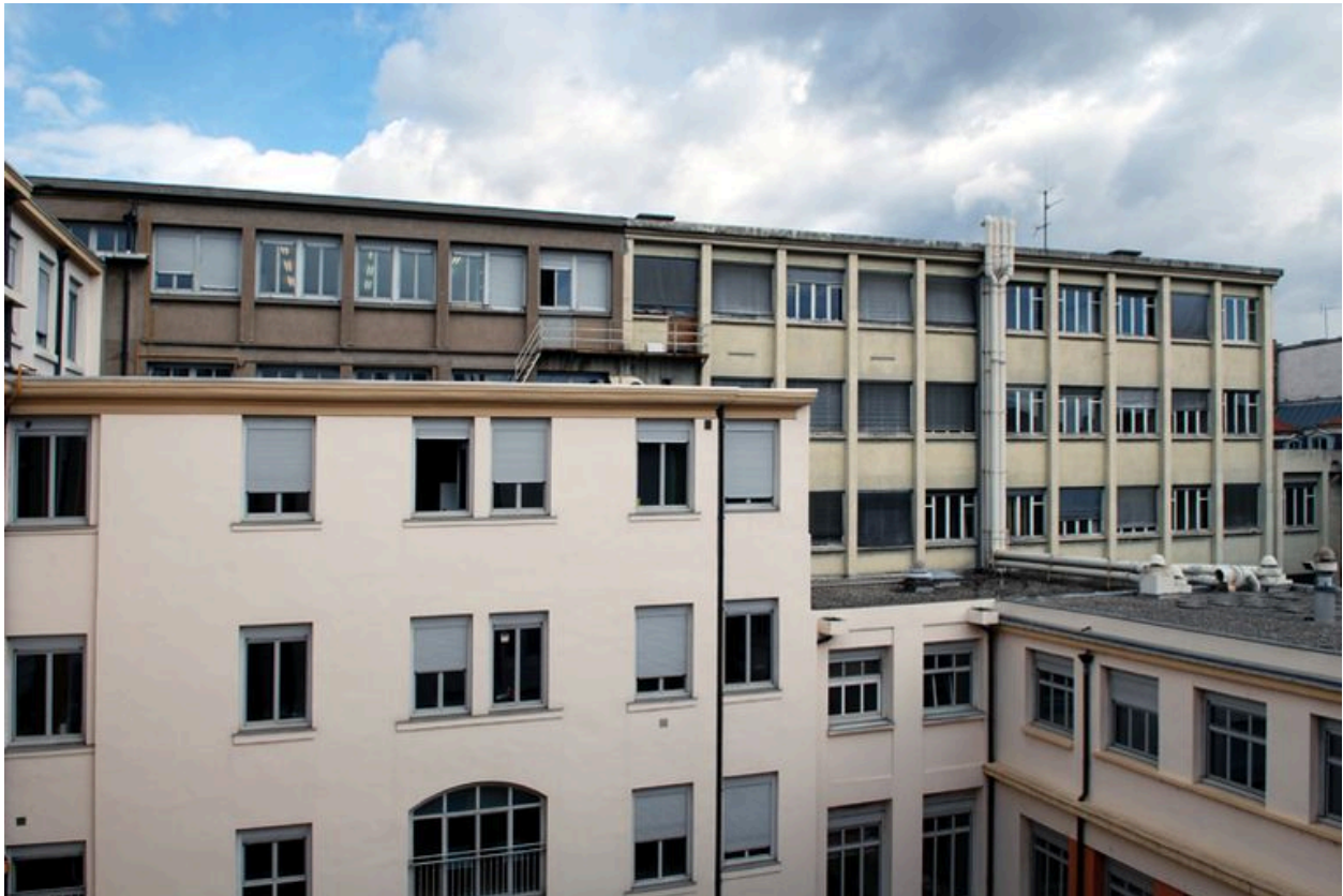
Cour intérieure, derniers niveaux des élévations sud et est, depuis le sud-ouest (à l'arrière-plan, élévation postérieure du bâtiment ISARA)
